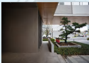
入口无障碍坡道
